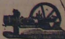
Máquina de vapor horizontal.
