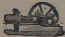
Máquina de vapor horizontal.
