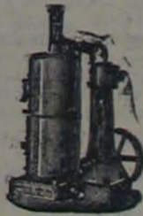
Máquina de vapor vertical
