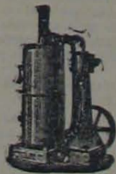
Máquina de vapor vertical
