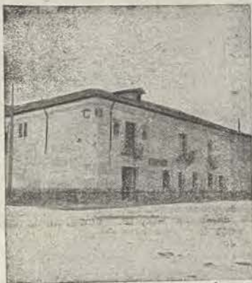
Edificio del Colegio
