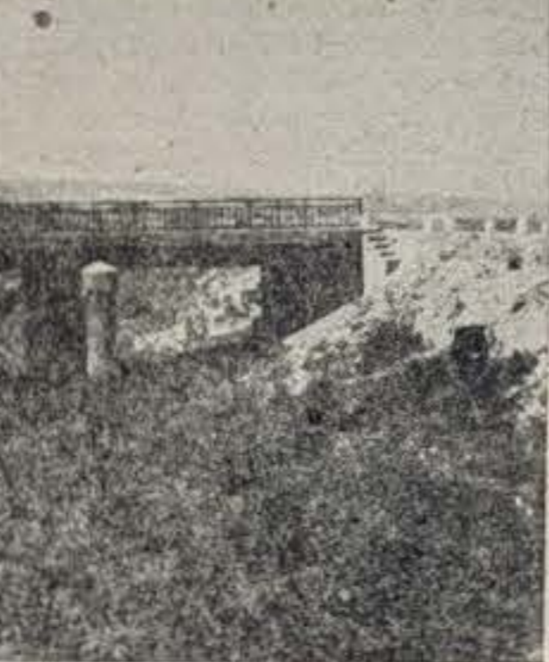
Uno de los pontones que Concentración Parcelaria ha construido sobre el Rio Zapardiel
